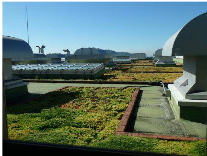
図 8-12 屋上緑化の例
