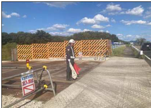
安全対策(誘導員の配置)
