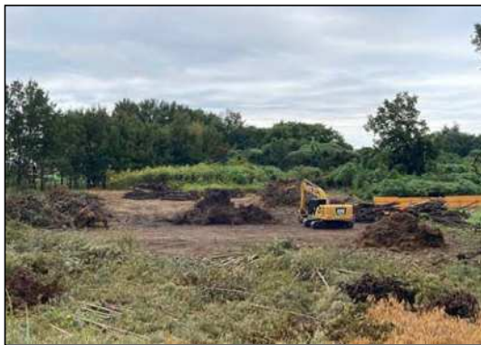
伐採工事施工状況(集積)
