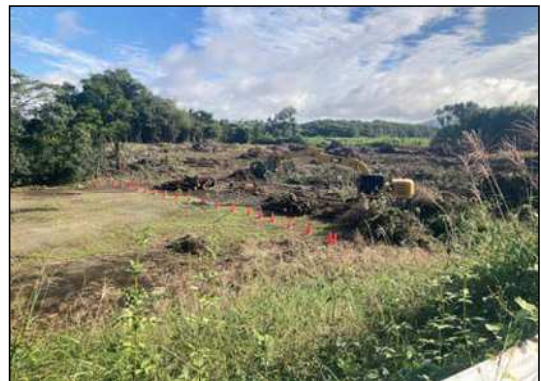
伐採工事施工状況(集積)
