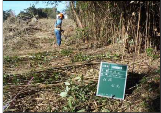
伐採工事施工状況(笹刈り)
