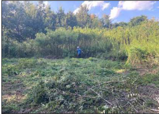
伐採工事施工状況(下草刈り)
