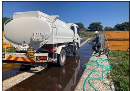
飛散汚染対策(タイヤの洗浄)
