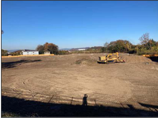
伐採工事施工状況
