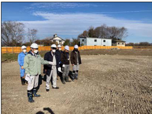
伐採・解体工事完了
