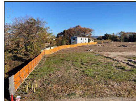
仮囲い設置状況
