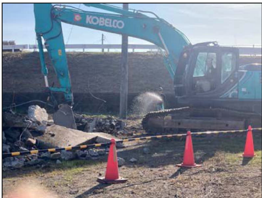
散水飛散養生（解体工事）
