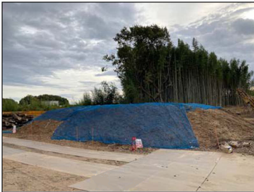
破碎材飛散養生（ネット）
