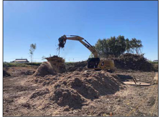
伐採工事施工状況（破碎）
