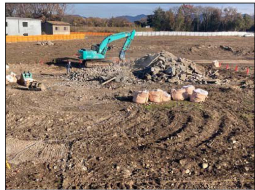
解体工事施工状況（工作物）
