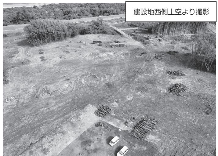
建設地の状況(令和5年11月末時点)
