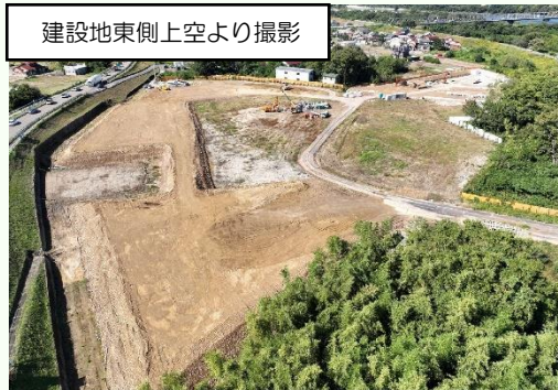
雨水調整池の整備状況
