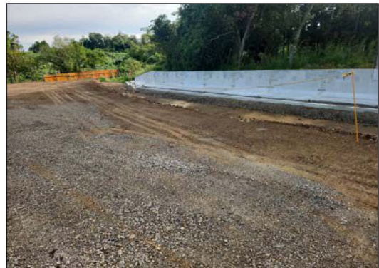
外構工事 擁壁据付状況（墓地西面）
