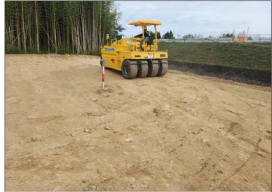
造成工事 盛土工施工状況
