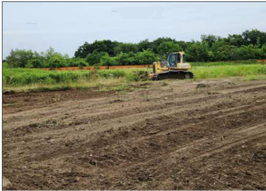
造成工事 表土鋤取り状況
