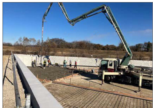
外構工事 調整池コンクリート打設状況
