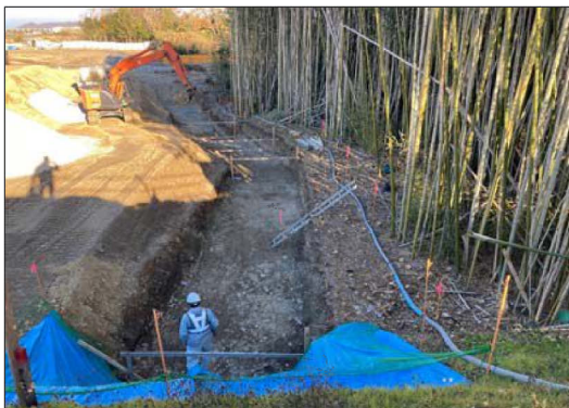
外構工事 大型ブロック積擁壁 掘削状況
