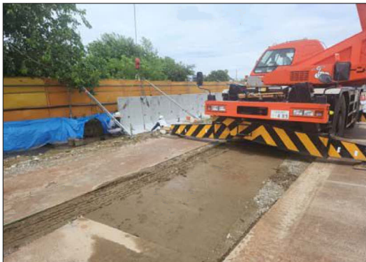
外構工事 擁壁据付状況（敷地北西）
