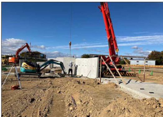
外構工事 擁壁据付状況（敷地南）
