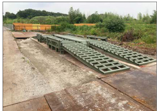
タイヤ洗浄機設置完了
