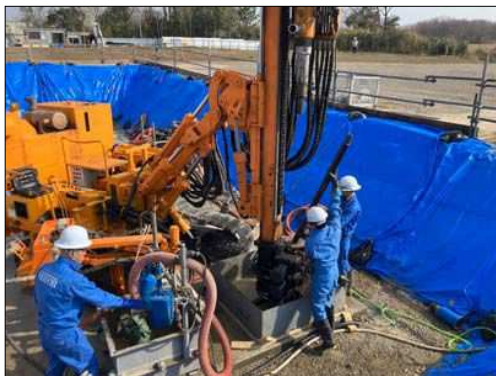
地業工事 地盤アンカー施工状況
