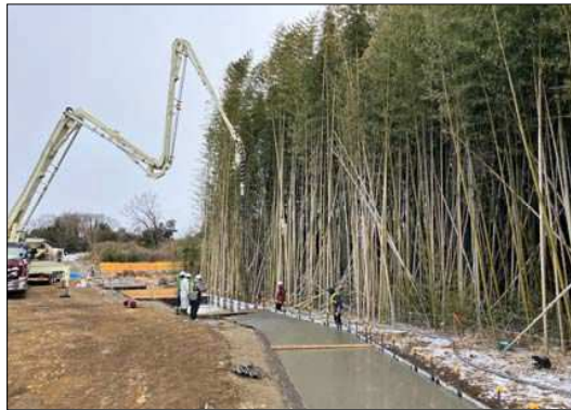
外構工事 大型ブロック積擁壁 コンクリート打設状況
