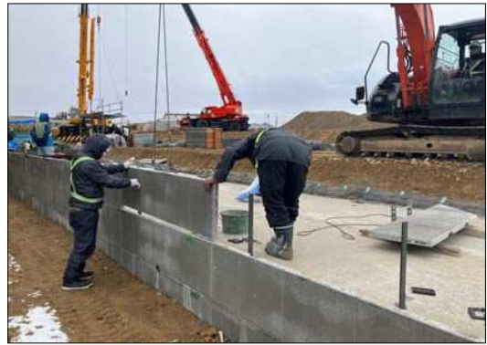
外構工事 大型ブロック積擁壁 化粧パネル設置
