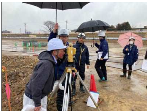
建物位置確認検査状況
