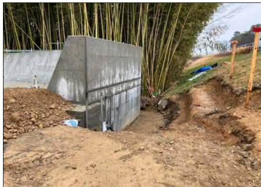
外構工事 大型ブロック積擁壁 施工完了
