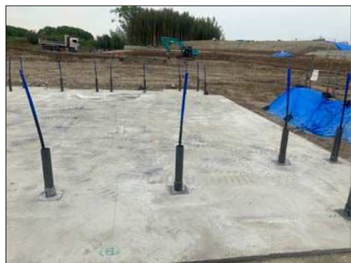
地業工事 地盤アンカー施工完了
