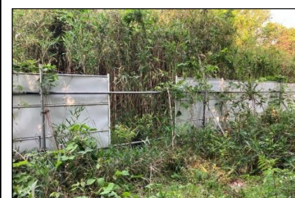
一部外した仮囲いの状況
