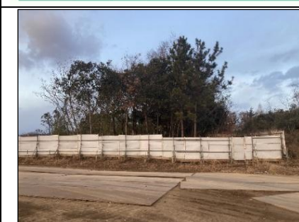
設置した仮囲いの状況
