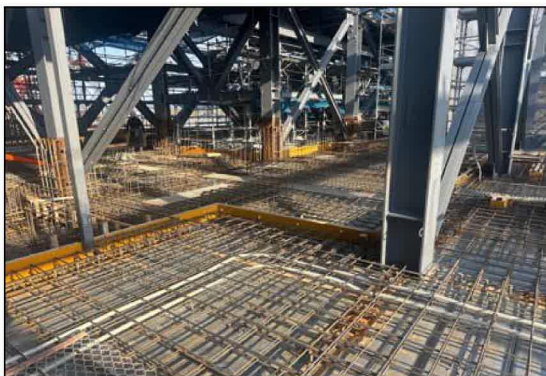
鉄筋工事 3Fスラブ配筋完了
