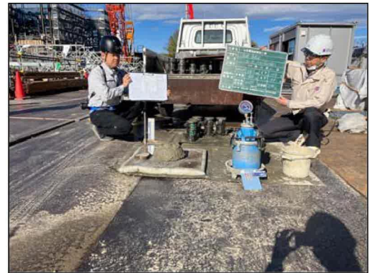
コンクリート受入試験
