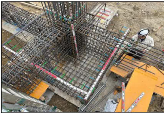
鉄筋工事 基礎配筋状況
