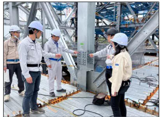
本締め立会い確認
