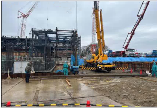
山留工事 山留撤去状況
