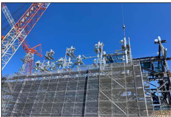
鉄骨工事 鉄骨建方状況(2)
