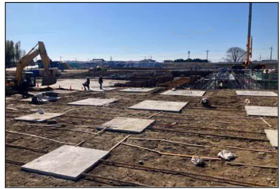
土工事 埋戻し完了
