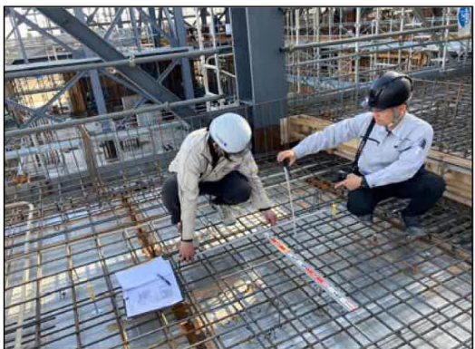
配筋検査（3階スラブ）
