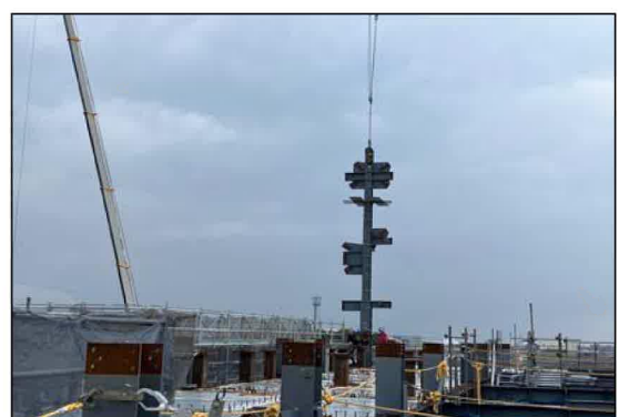
鉄骨工事 鉄骨建方状況(1)
