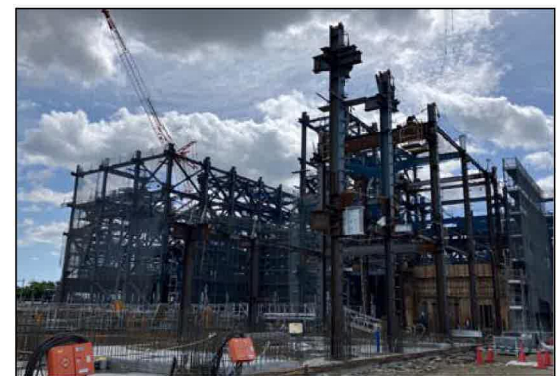
鉄骨工事 鉄骨建方状況(3)
